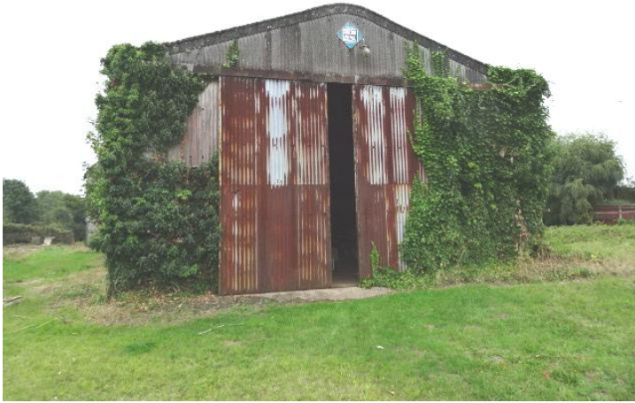
NE gable end
