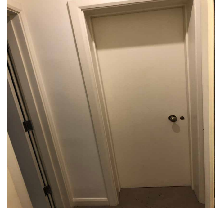
existing door (DB.05)
