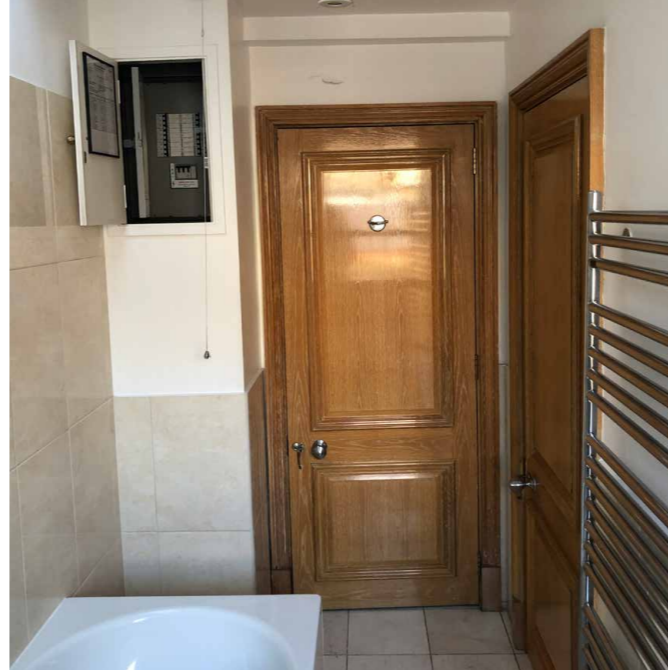
existing door (DS.01)
