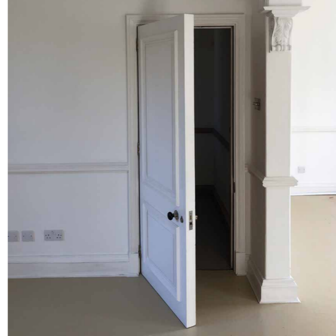
existing door (DF.02)
