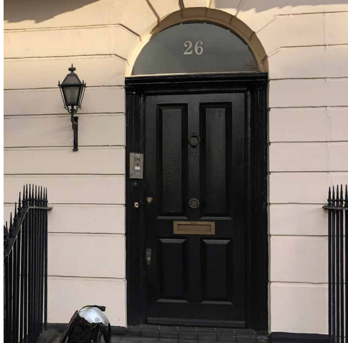
existing door (DG.01)
