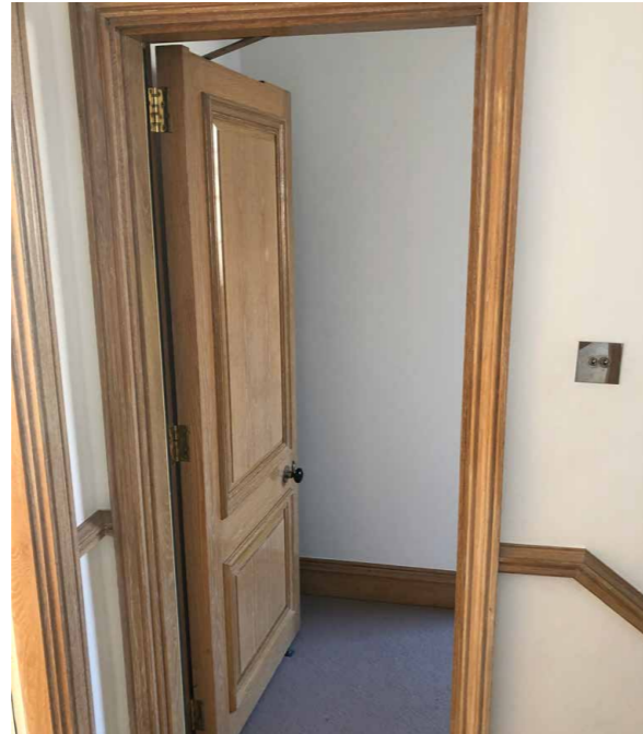
existing door (DS.03)
