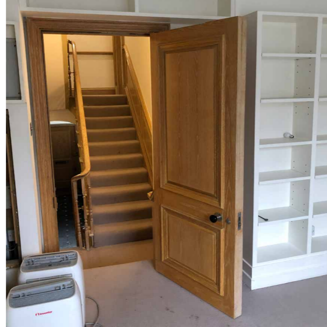
existing door (DF.01)
