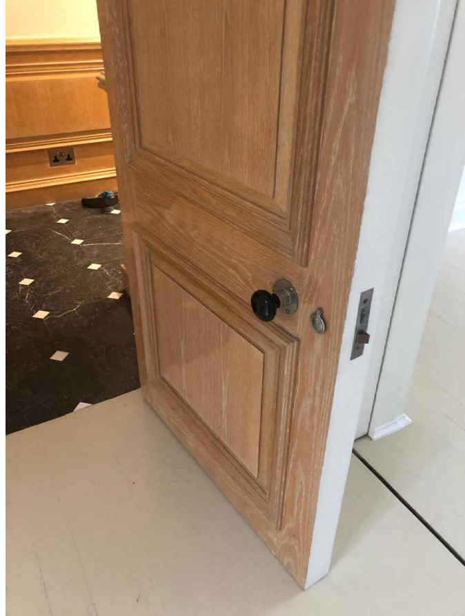
existing door (DG.02)
