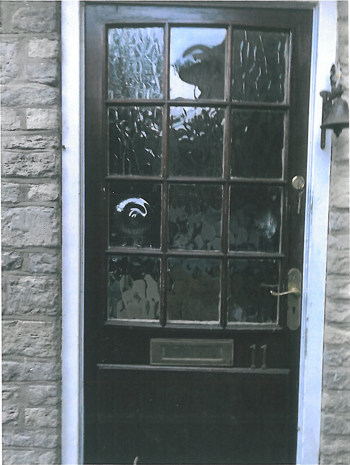
EXISTING BACK DOOR
