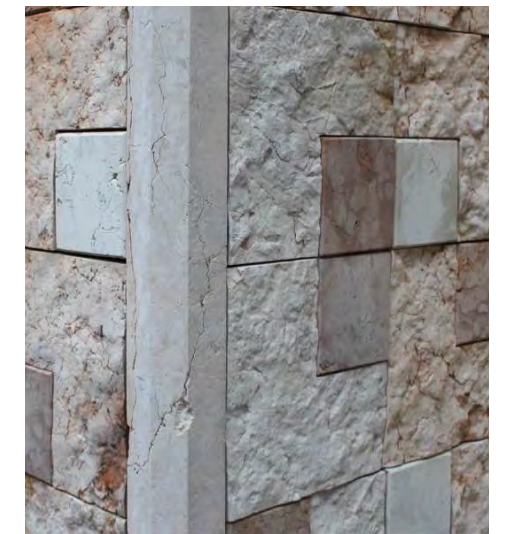
Exterior Stonework - Museo di Castelvecchio - Carlo Scarpa
