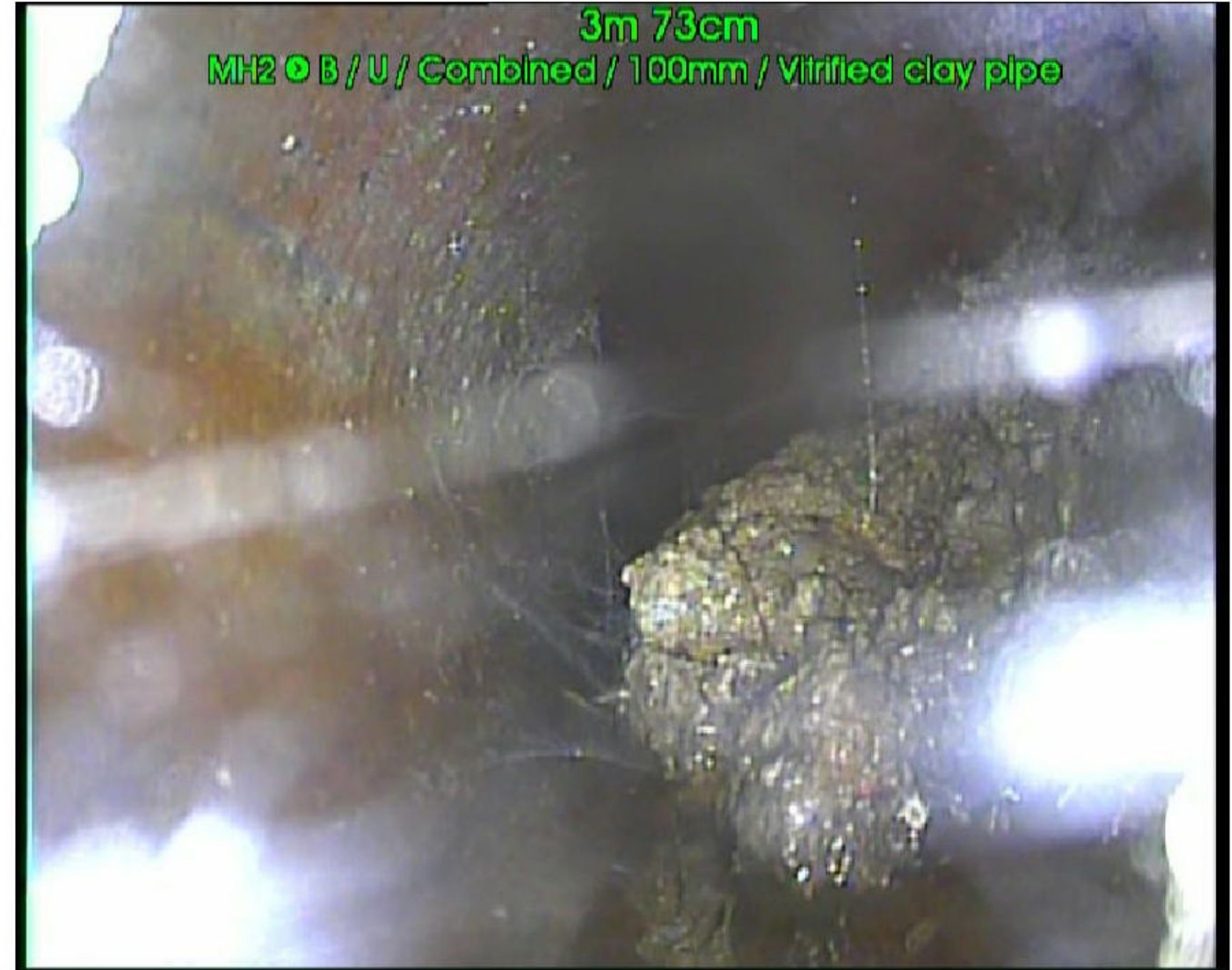
Photo: 5_5_20_A.jpg 3.73m, Roots, fine F1
