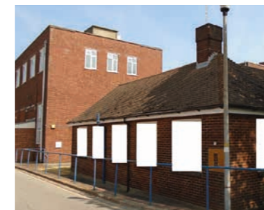
Q14 – South elevation (behind Q12)
