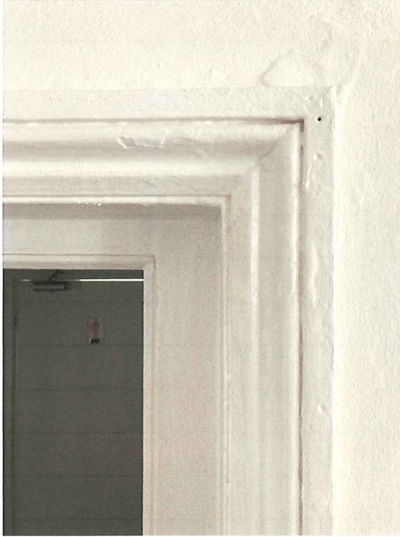
Fig 16 - Ogee architrave - Doorway D.5.
