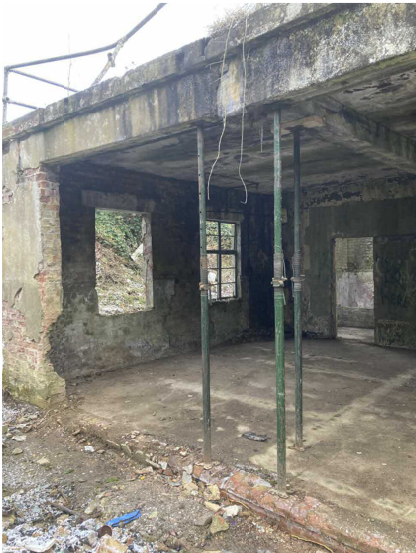
) UJXUH 5 HDUHFYDVFQRHJ WQQLRQ P LVVLQJ PD VRQUSLH
