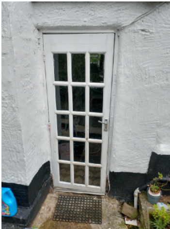
Existing Back door
