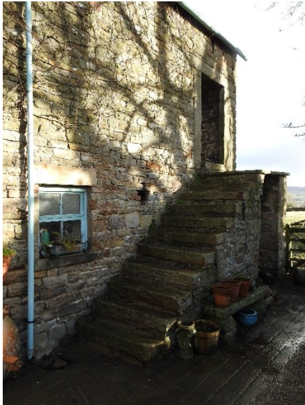
Existing external hay loft stair
