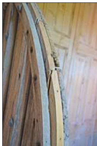
Plate 48: F6: door detail
