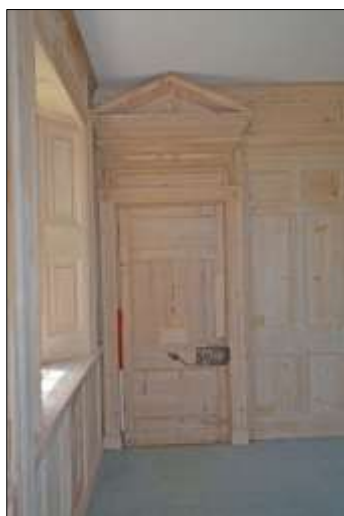
Plate 44: F5: door detail
