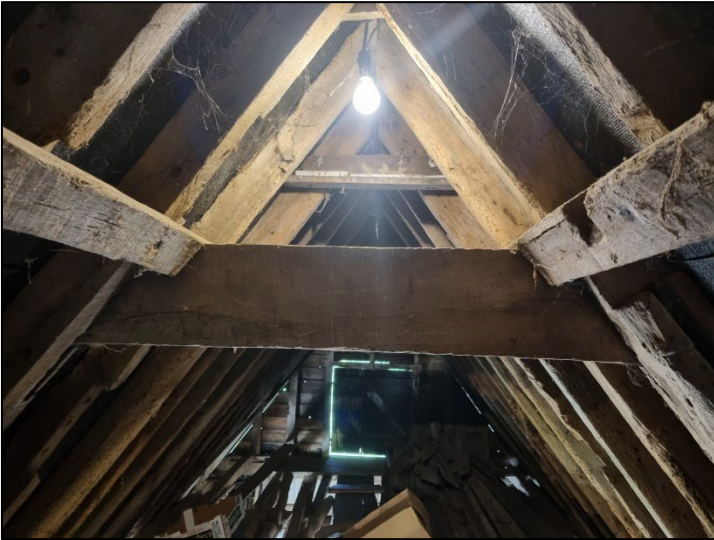
d) Barn loft void
