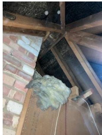
Figure 27. B1, loft void 1.
