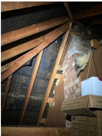
Figure 26. B1, loft void 1.
