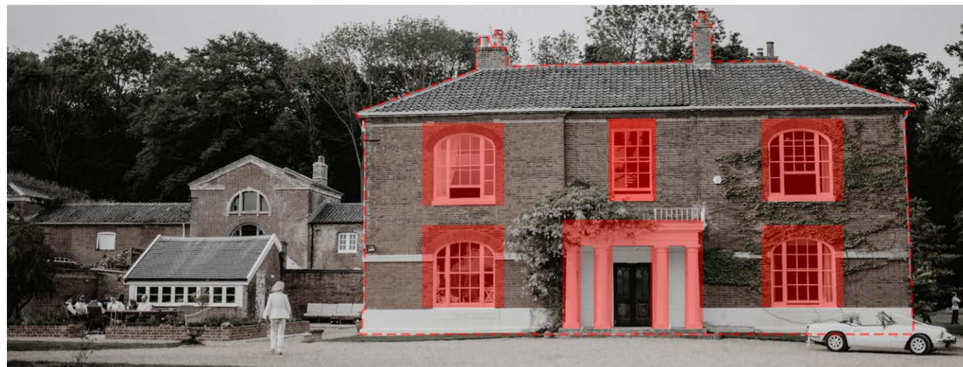
V3 - Tripartite sash windows - Rubbed brick voussoirs - Tuscan columns - entablature
