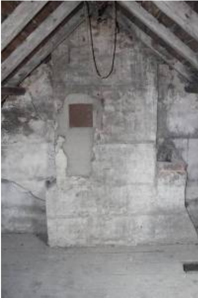
N. gable soot door
