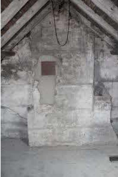
N. gable soot door
