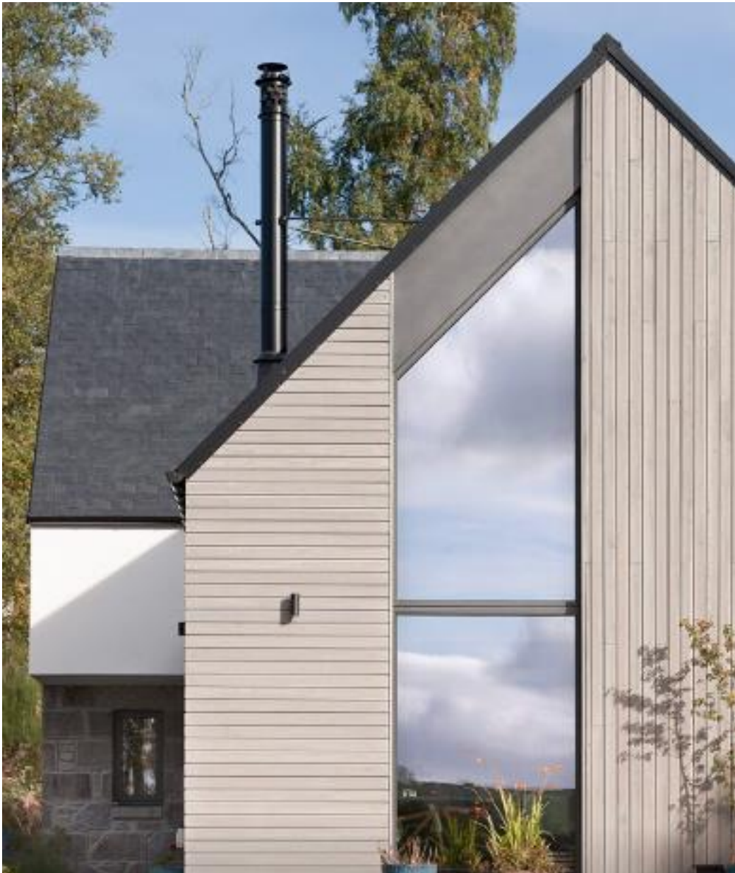
Fig 18: SiOO:X coating on Siberian Larch
