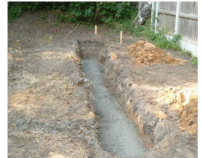
PHOTO OF CONCRETE POUR TO FOUNDATION
