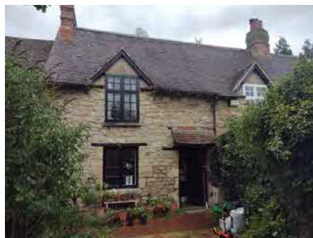
1a Mill Lane
