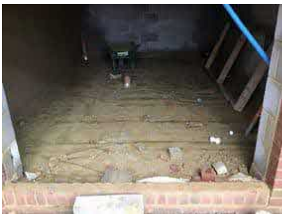
Incomplete bin store.
