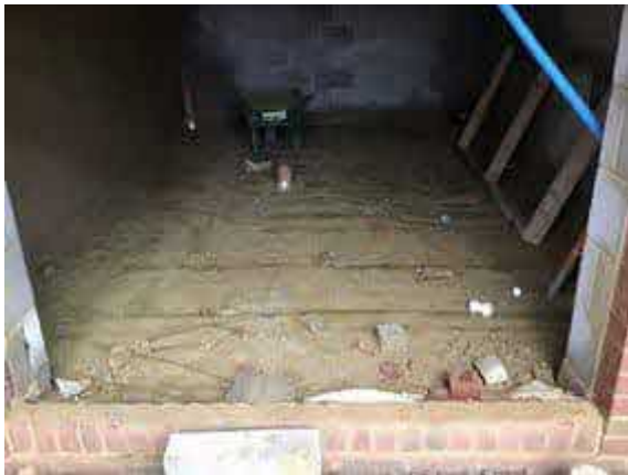
Incomplete bin store.
