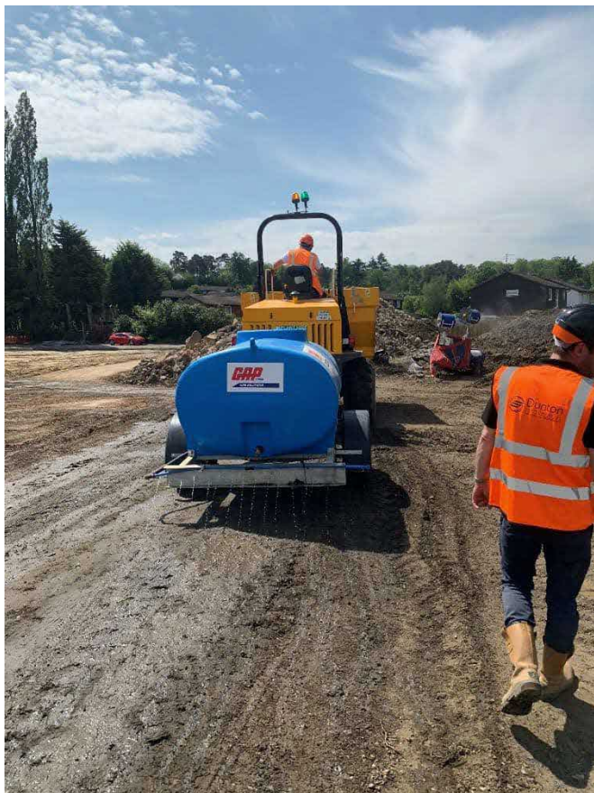
Mobile dust suppression
