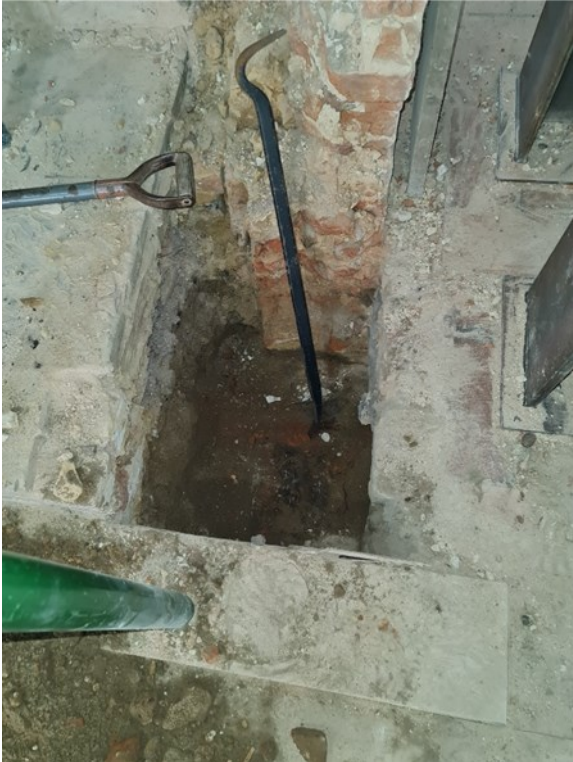
P.17 - GF Lounge / Stairwell
