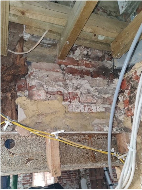
P.19 - GF Stairwell
