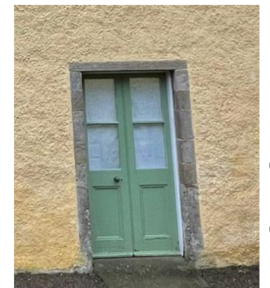
Existing double door
