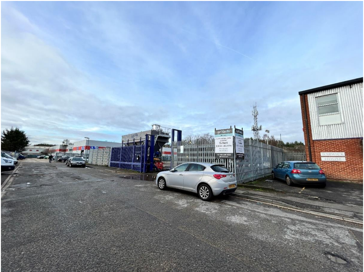
Site frontage (Jan 2023)
