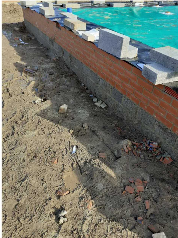
05 C8585E 29.09.22 Plot 49 Void Space Vents
