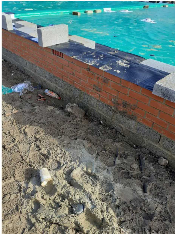
05 C8585E 29.09.22 Plot 50 Void Space Vents
