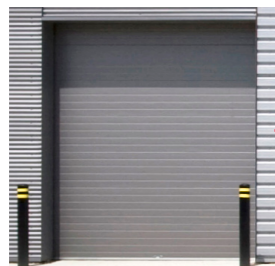
Loading door & Bollards
