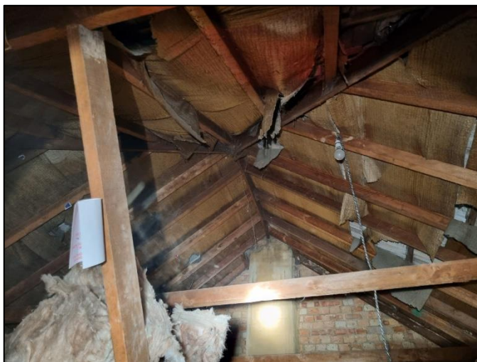
c) Loft void.
